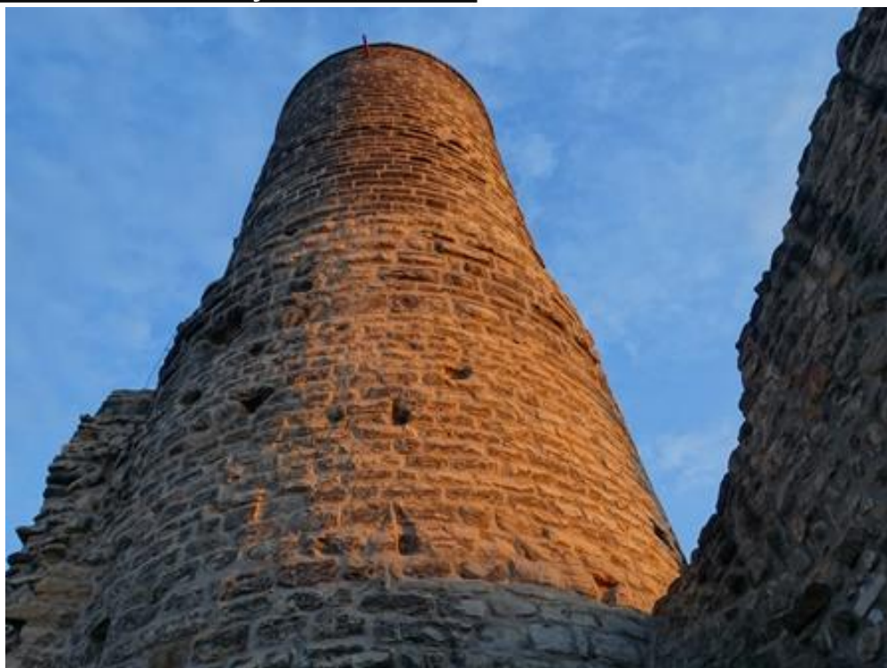
Foto po ukončení rekonstrukce vnějšího pláště hradní věže
