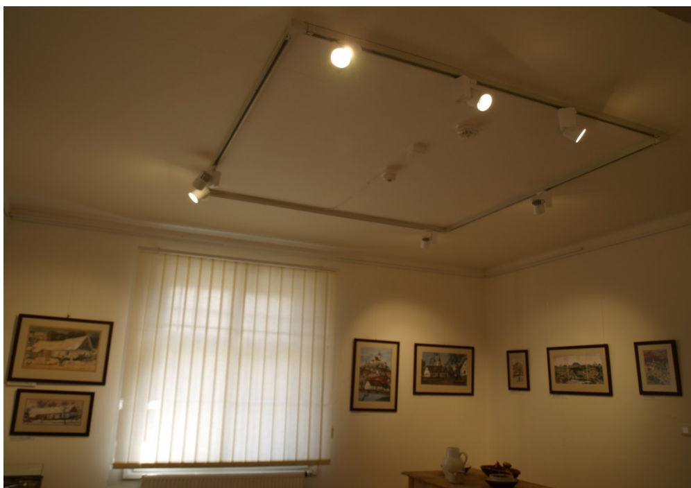
Výměna starého osvětlení za nové
