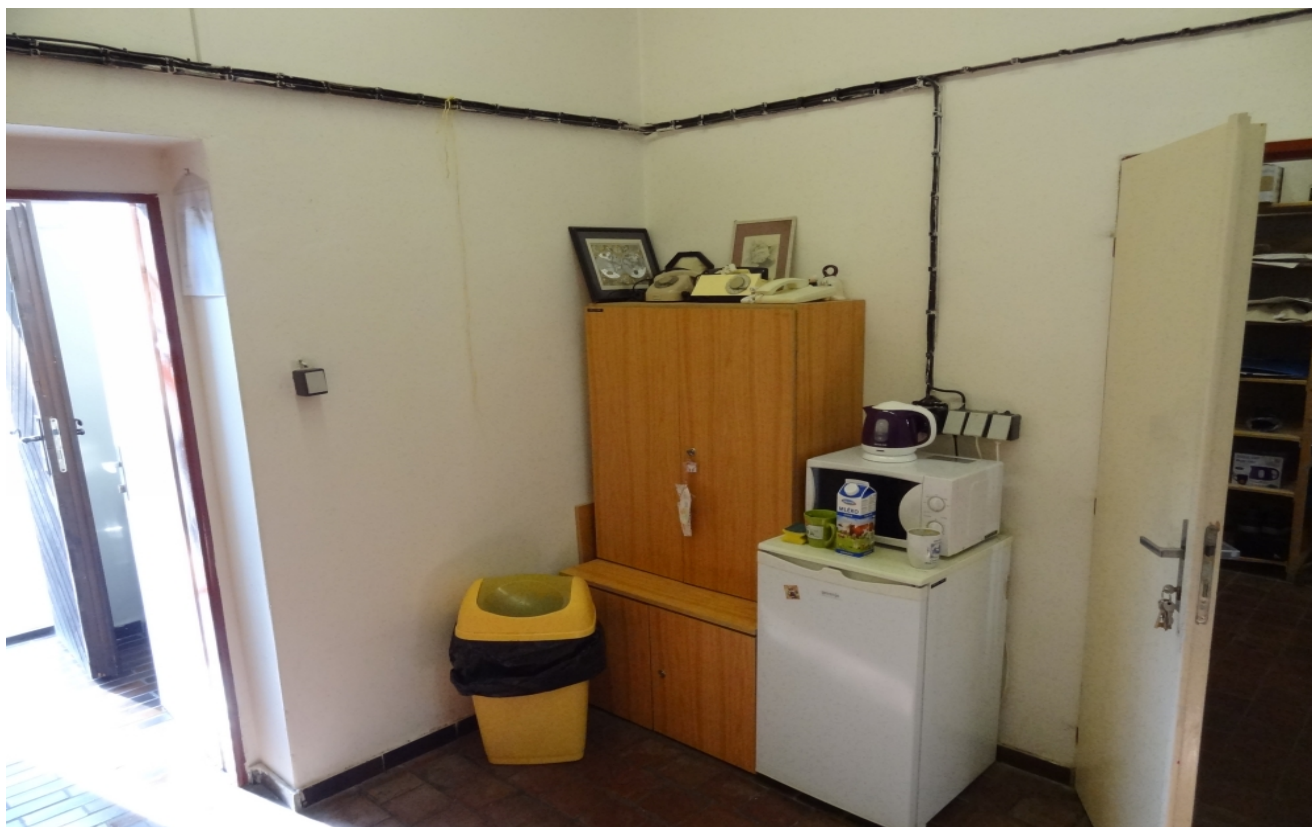
Prostor čajové kuchyně před úpravou ...
