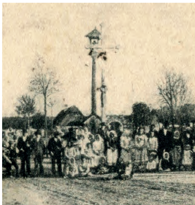
Sloupová zvonička s předstojícím dřevěným křížem, kolem 1910? (archiv OÚ Lhota, pohlednice).
