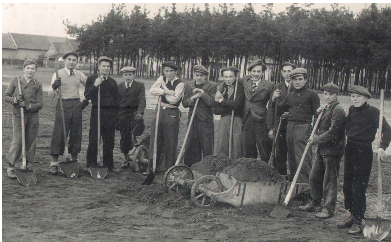
Budování či úprava hřiště u lesa, 30.-40. léta 20. století (soukromý archiv rodiny Pilařovy).
