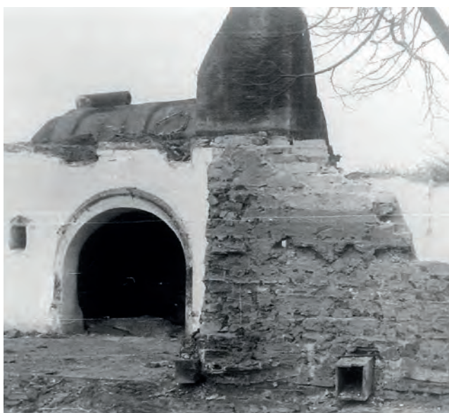
Černá kuchyně zachycená během demolice čp. 12, 1960 (archiv OÚ Lhota, foto Miroslav Gottlieb).
