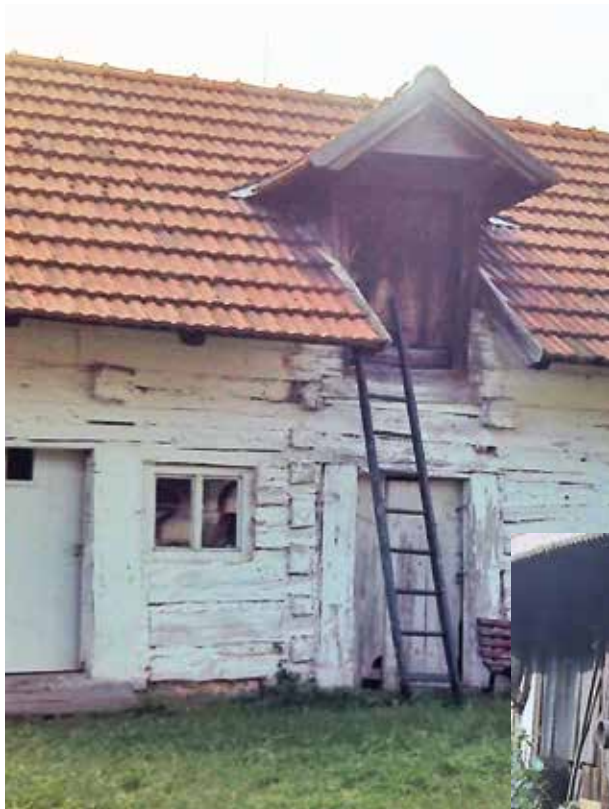
Zachovalá roubená konstrukce při čp. 9.
