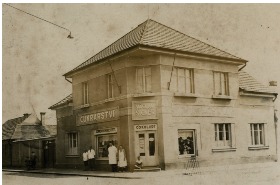
Později postavený rodinný dům-prodejna naproti škole existuje dodnes.
