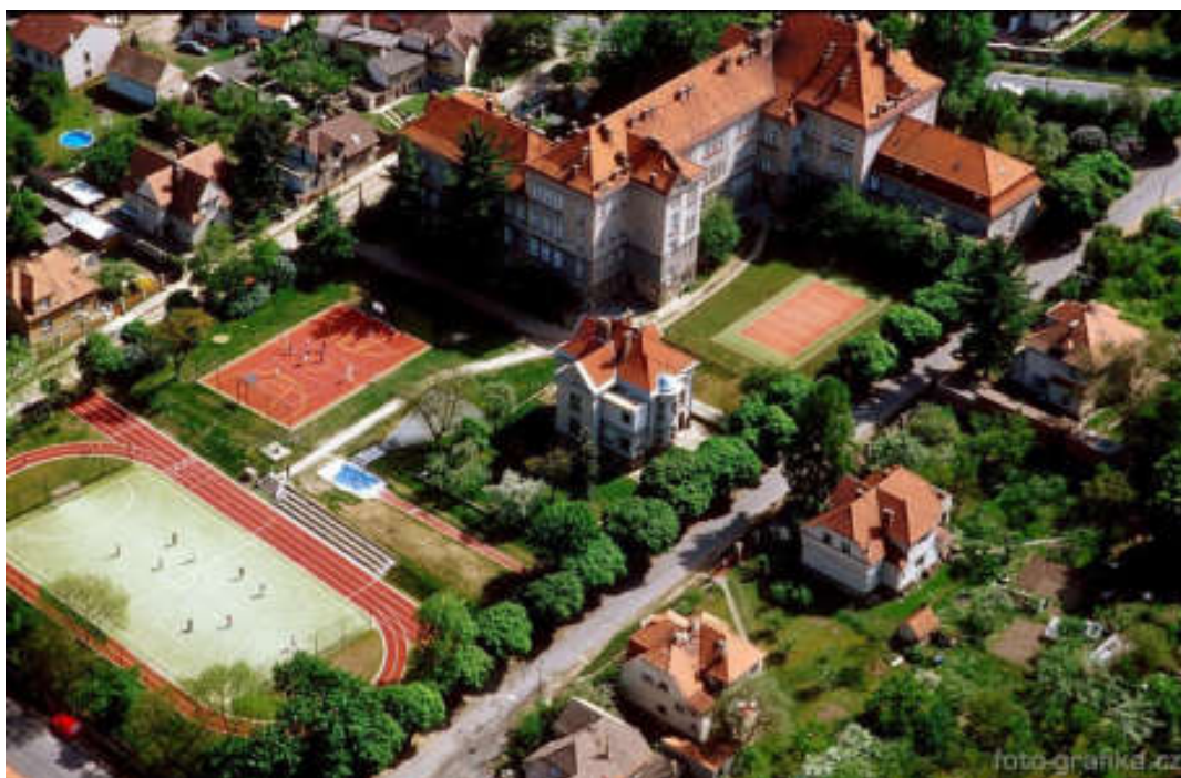
[obr. 36] VODĚRA, Kamil. [Gymnázium J. S. Machara: pohled od severu] [fotografie]. 2003.
