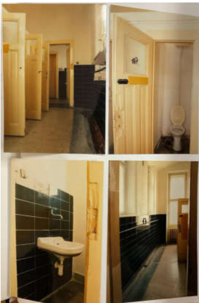
[obr. 35] WC chlapci: stávající stav [fotografie]. [2000]. In: Rekonstrukce sociálního zařízení I. etapa . Brandýs nad Labem – Stará Boleslav, 2000. Gymnázium J. S. Machara Brandýs nad Labem – Stará Boleslav.
